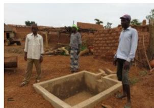
Biodigester (en construction) produit du gaz pour cuisiner, s'éclairer et de l'engrais
