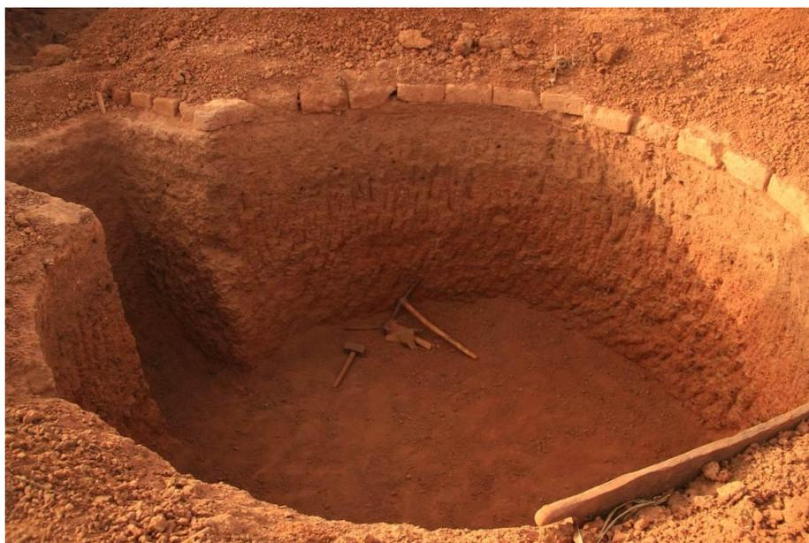
**Photo 8** : Trou installé pour l'emplacement du futur biodigesteur.
