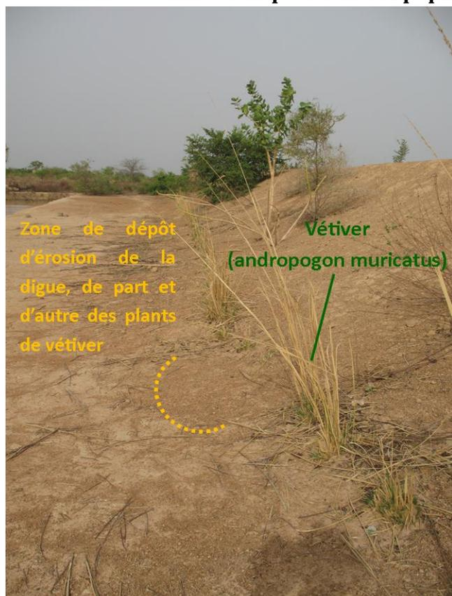
**Photo 3 :** Vétiver planté en bord de digue pour lutter contre l'érosion à la ferme de Guié.
